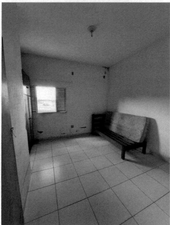
10 Consultório Clínica Médica - instalação de lavatório para higienização das mãos
